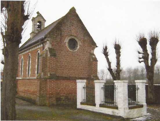
Par rapport aux dessins du projet, l'ouverture de la chapelle a été inversée (photo actuelle)
